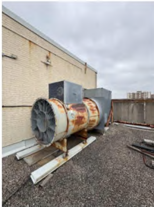
Photo #19: AHU-1 Exhaust Fan
