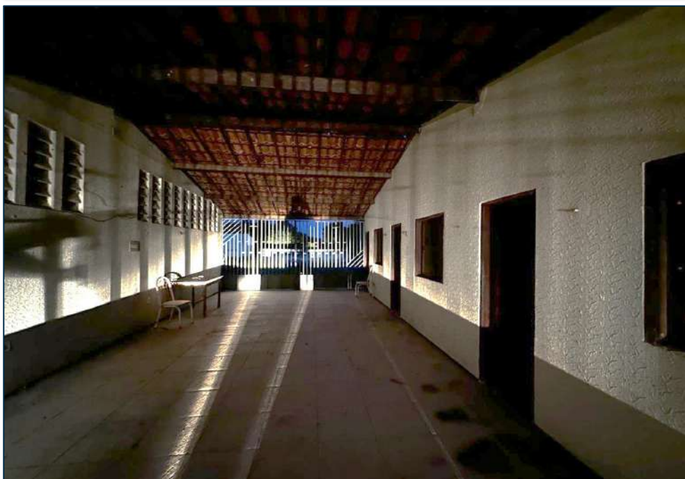
Interior do barracão para acesso aos cômodos
