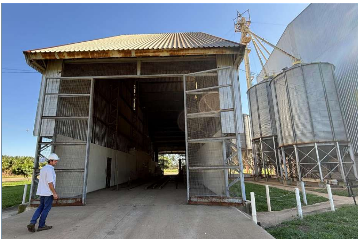
Área de descarga e Silos de armazenamento de insumos
