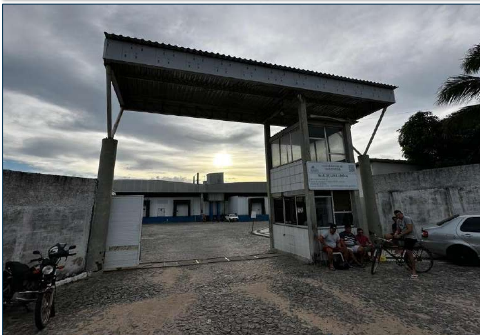
Entrada do Frigorífico
